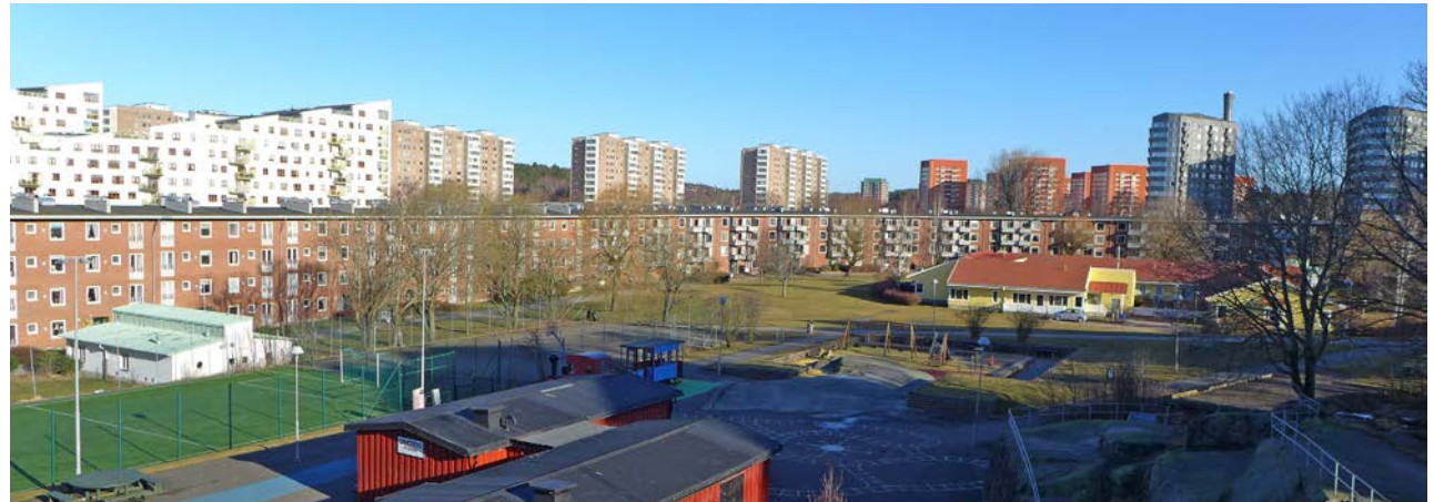
Vy från Södra Dragspelsgatan där de olika bostadsenklaverna är tydligt ut läsbara. Här kan man i ett slag uppleva de ideal som satte sin prägel på utredningsområdet med sina nya förhållningssätt till bostadsbyggande och stadsplanering.
